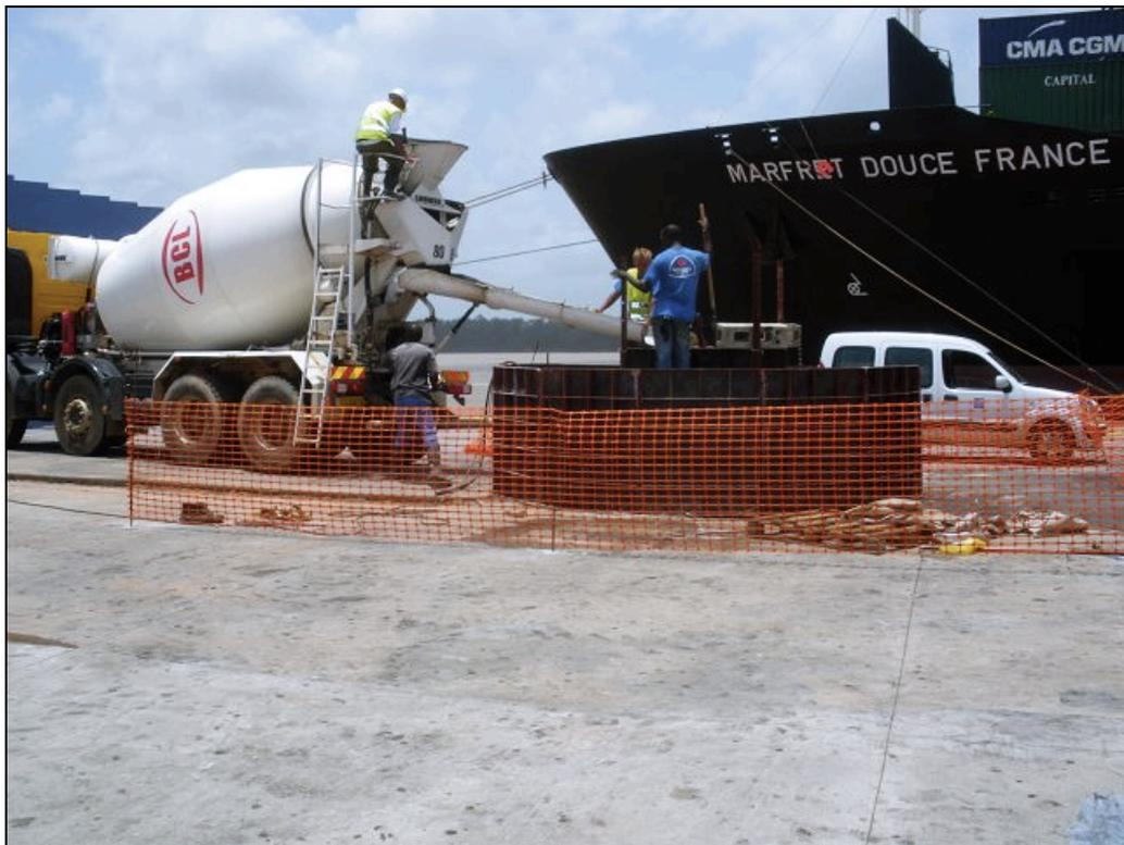
07/04/09 : bétonnage du massif du mât d'éclairage déplacé
