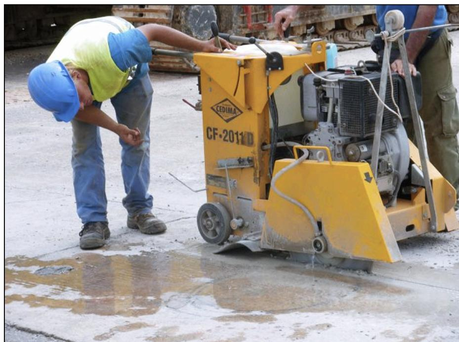
01/04/09 : sciage de la chaussée pour la mise en œuvre des pieux d'amarrage provisoire
