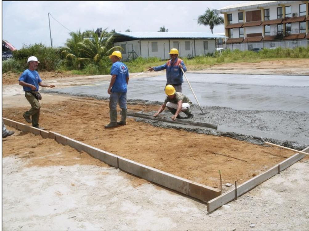
30/04/09 : bétonnage de la dalle pour l'aire de préfabrication
