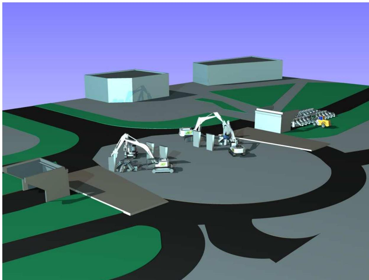
❖ Broyage des piles avec 2 pelles de 50T équipées de cisaille béton.
